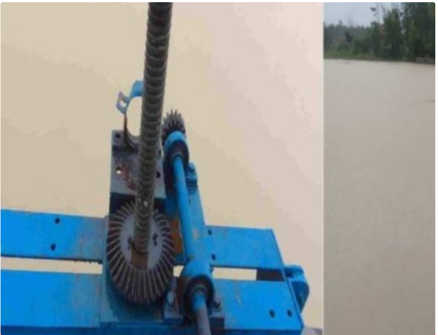
Pintu air Albaret Simpang Mesuji
